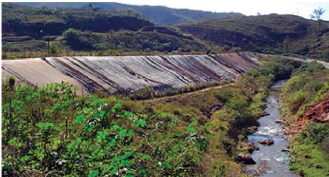
Depósito de relaves Galo, en la margen del río Cardoso, en 2004, antes del inicio de los trabajos de rehabilitación. Nótese el talud cubierto por geomembrana PVC para protección contra erosión y para evitar el transporte de relaves.
