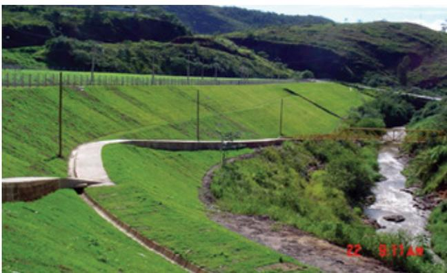
Depósito de relaves Galo en 2005, después de la conclusión de los trabajos de rehabilitación, observándose el talud revestido con gramíneas, el drenaje de aguas pluviales, una berma y un puente nuevo, solicitado por los moradores.
