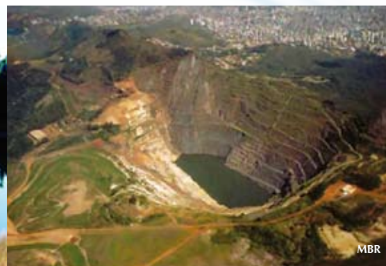
Barragem em áreas de mineração
